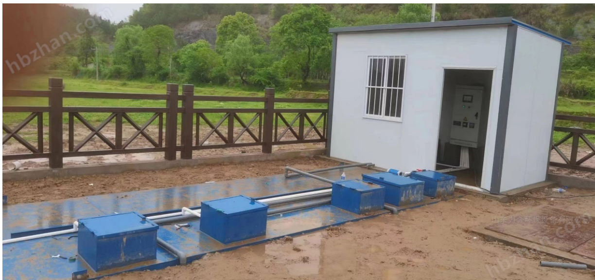
图 1：地埋式污水处理设备：地埋式污水处理设备是一种高效、集约、环保的分散式污水处理解决方案，完美契合了度假村对生态环保、景观协调和可持续运营的需求。它能有效处理运营中产生的生活污水，实现水资源的循环利用（如灌溉绿化），是打造绿色、高品质度假村不可或缺的基础设施。
