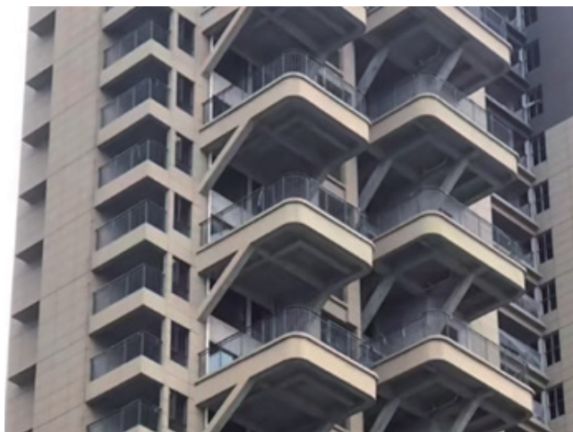
外挑露台采用斜撑的效果
